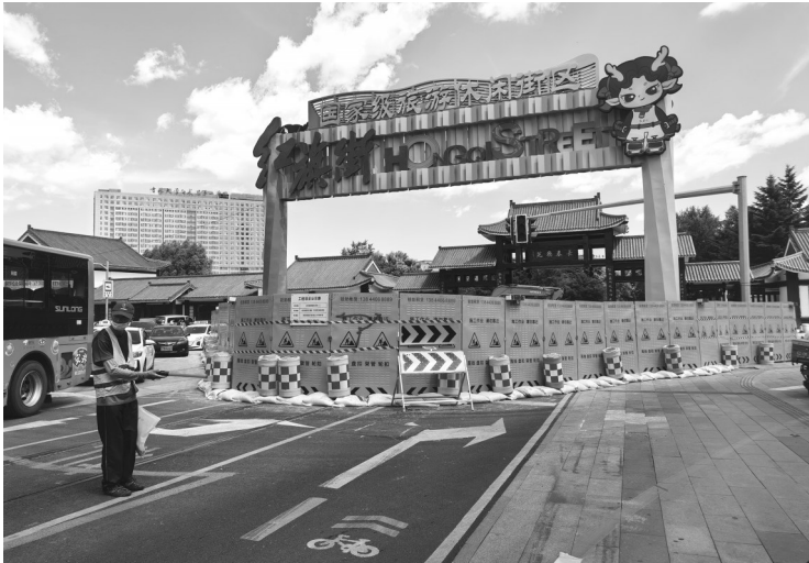
施工区域围起围挡 本组图片 城市晚报全媒体记者 陆续 实习生 孙之尧 摄
