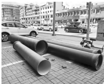
准备更换的雨水管线
