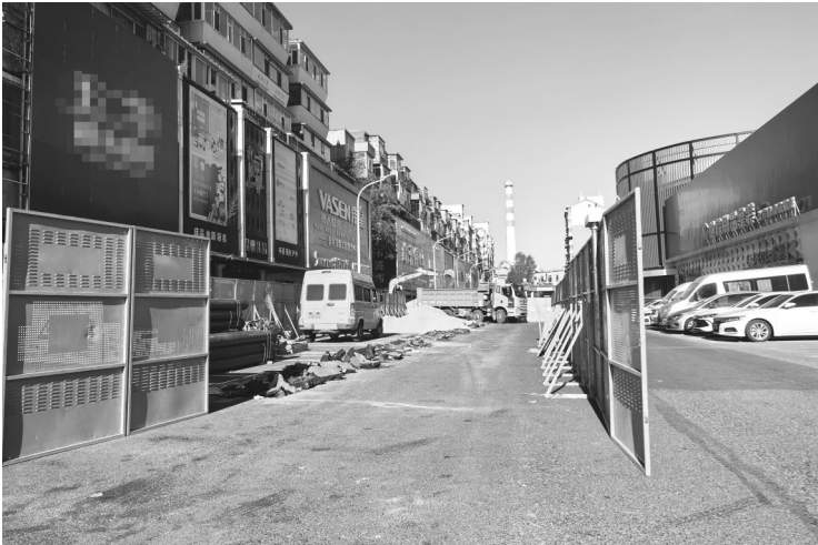
围挡圈出作业区 城市晚报全媒体记者 陆续 摄
