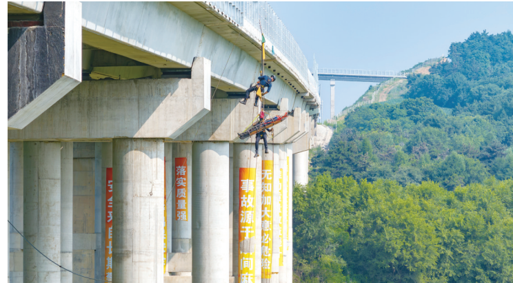
消防队员利用绳索系统,搭建救援通道,营救被困群众
