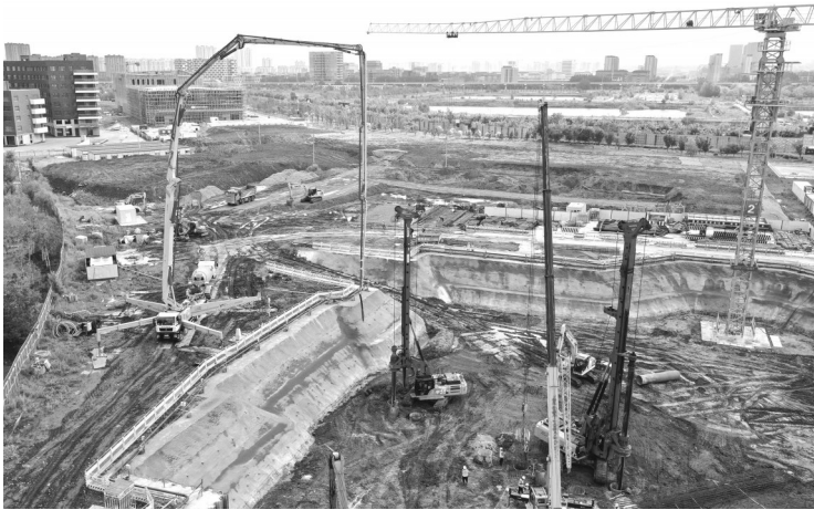
施工现场 长春新区供图
