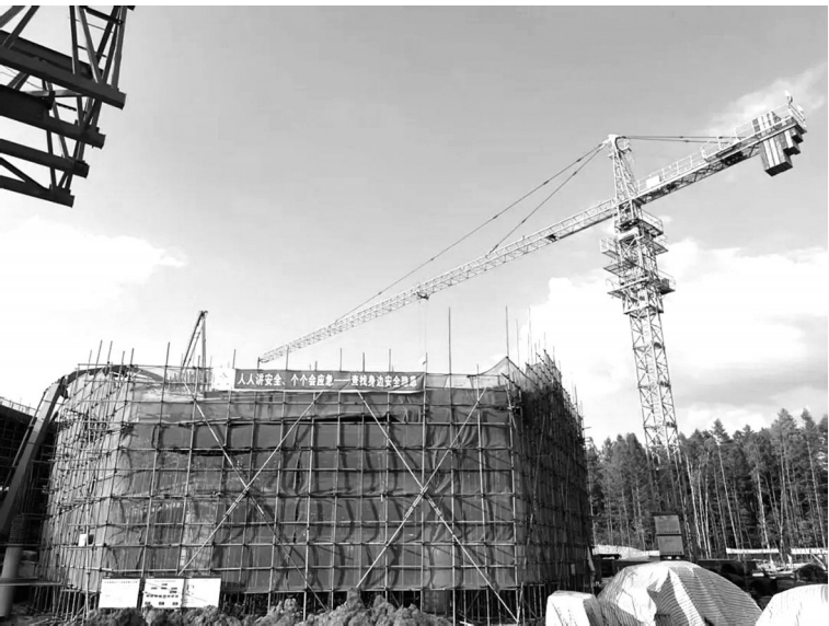
综合楼主体封顶 省高建局供图
