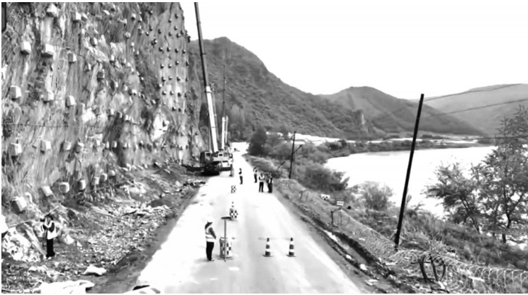
施工有序推进 省高建局供图
