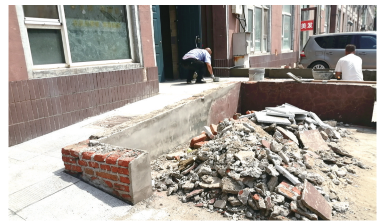
单元门改造坡道
