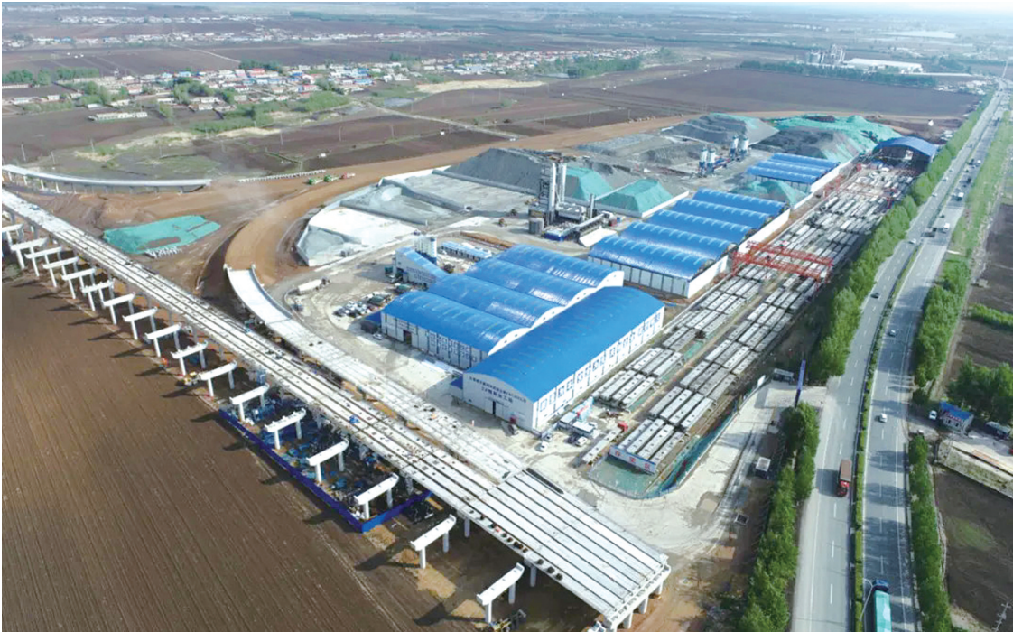
长春都市圈西环高速项目现场 吉高集团供图
