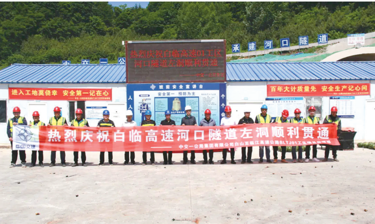
河口隧道顺利贯通 省高速公路集团供图
