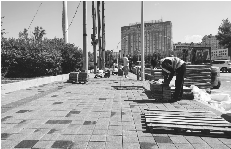
人行道方砖的铺设已接近尾声 本组图片 城市晚报全媒体记者 陆续 摄
