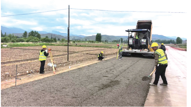
试验段摊铺施工 省高建局供图
