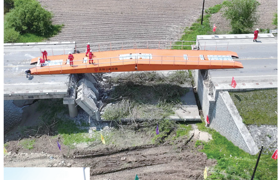
桥梁应急抢险 本组图片 省交通运输厅供图
