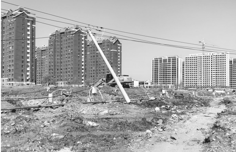
项目正在施工中 本组图片 城市晚报全媒体记者 陆续 摄
