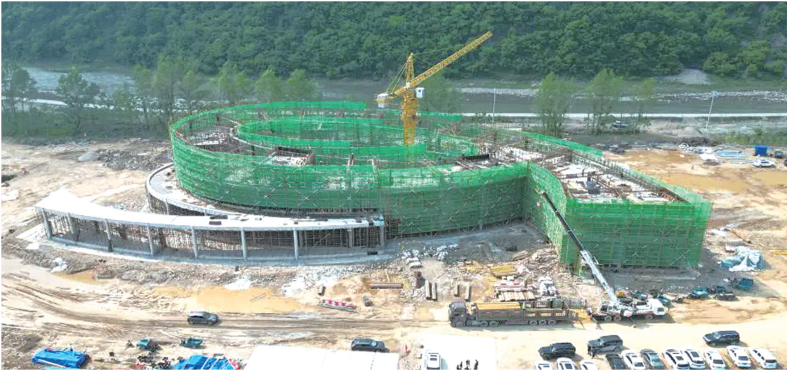
综合楼主体封顶 省高建局供图
