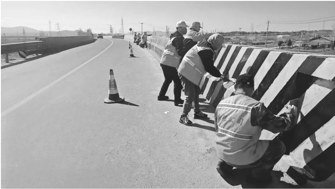
沿线桥梁刷油重涂 本组图片 各公路管养单位供图
