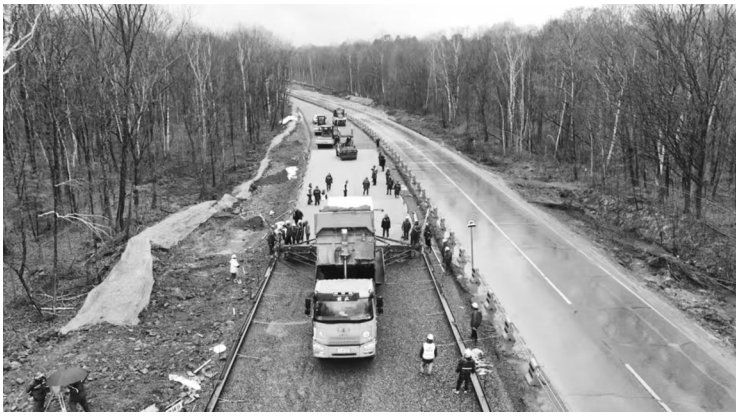
大型机械正在施工作业 省交通运输厅供图
