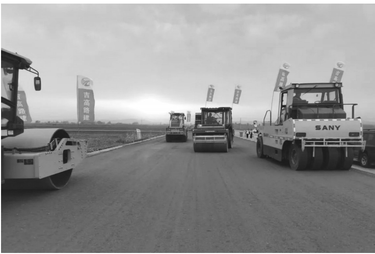
长春都市圈西环高速公路施工现场 吉林省高速公路集团供图
