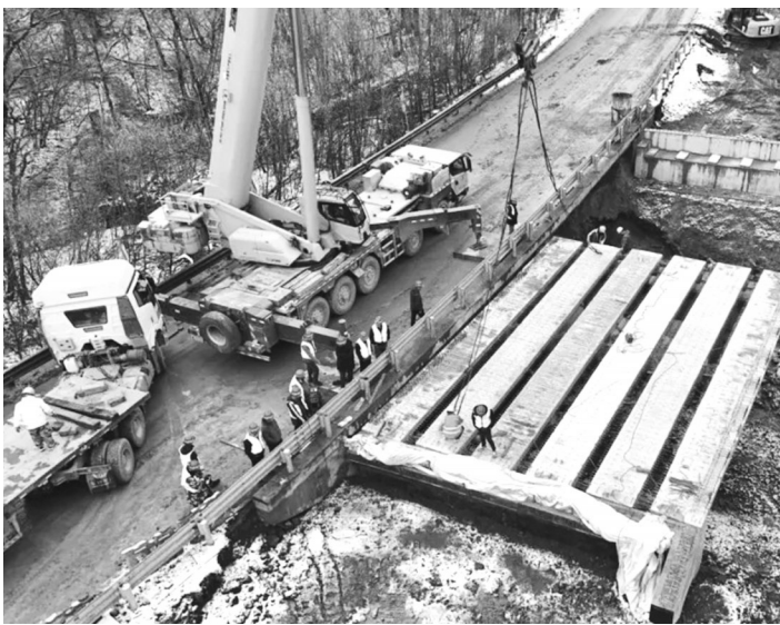
桥梁完成架设 省高建局供图
