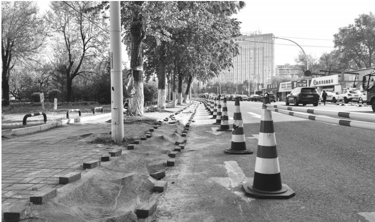
幸福街两侧的边石已经拆除 本组图片 城市晚报全媒体记者 陆续 摄
