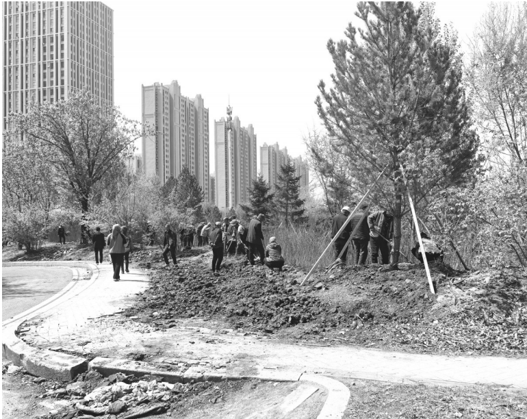
现场正在施工中 本组图片 城市晚报全媒体记者 陆续 摄
