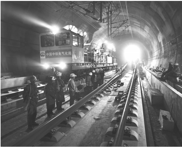
施工人员在加紧施工 于逍 摄
