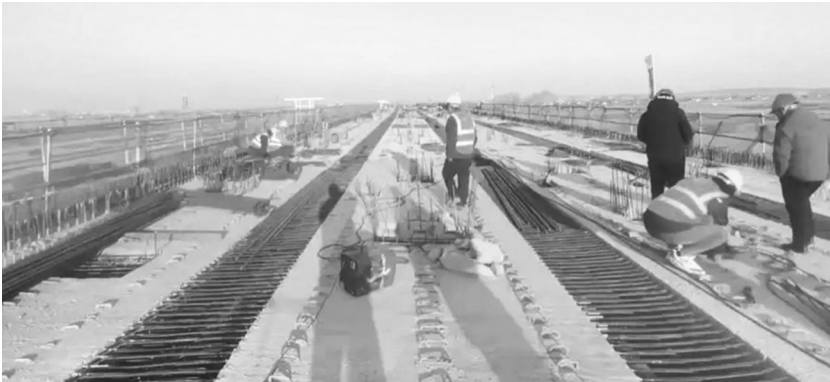
建设者们正在忙碌中 吉高集团供图
