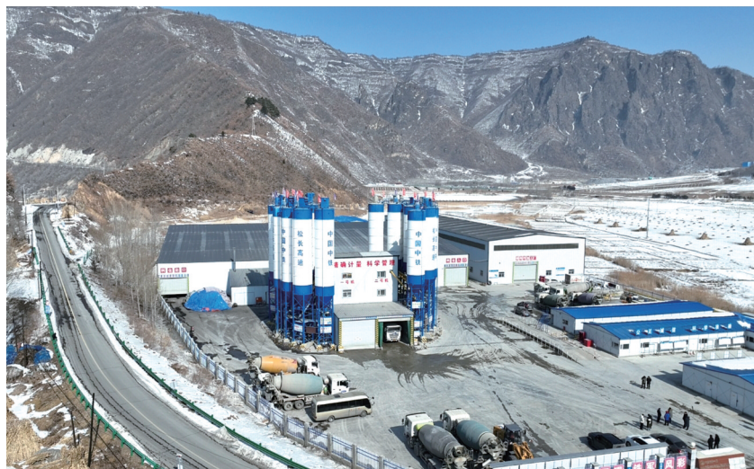
施工现场 省公路局供图
