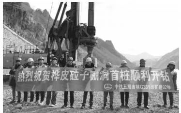
首根桩基顺利开钻 省高建局供图
