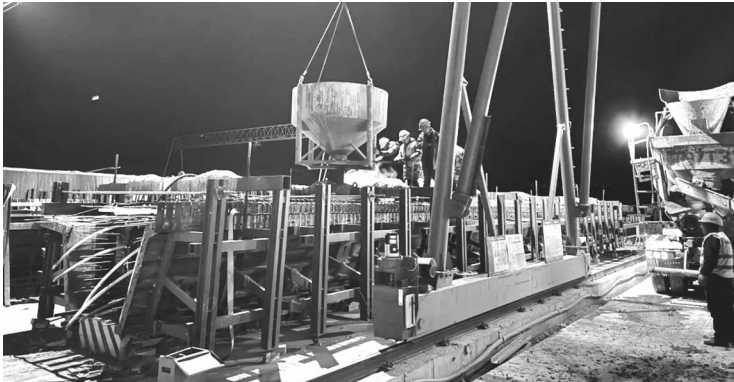
首片预制梁成功浇筑 吉高集团供图
