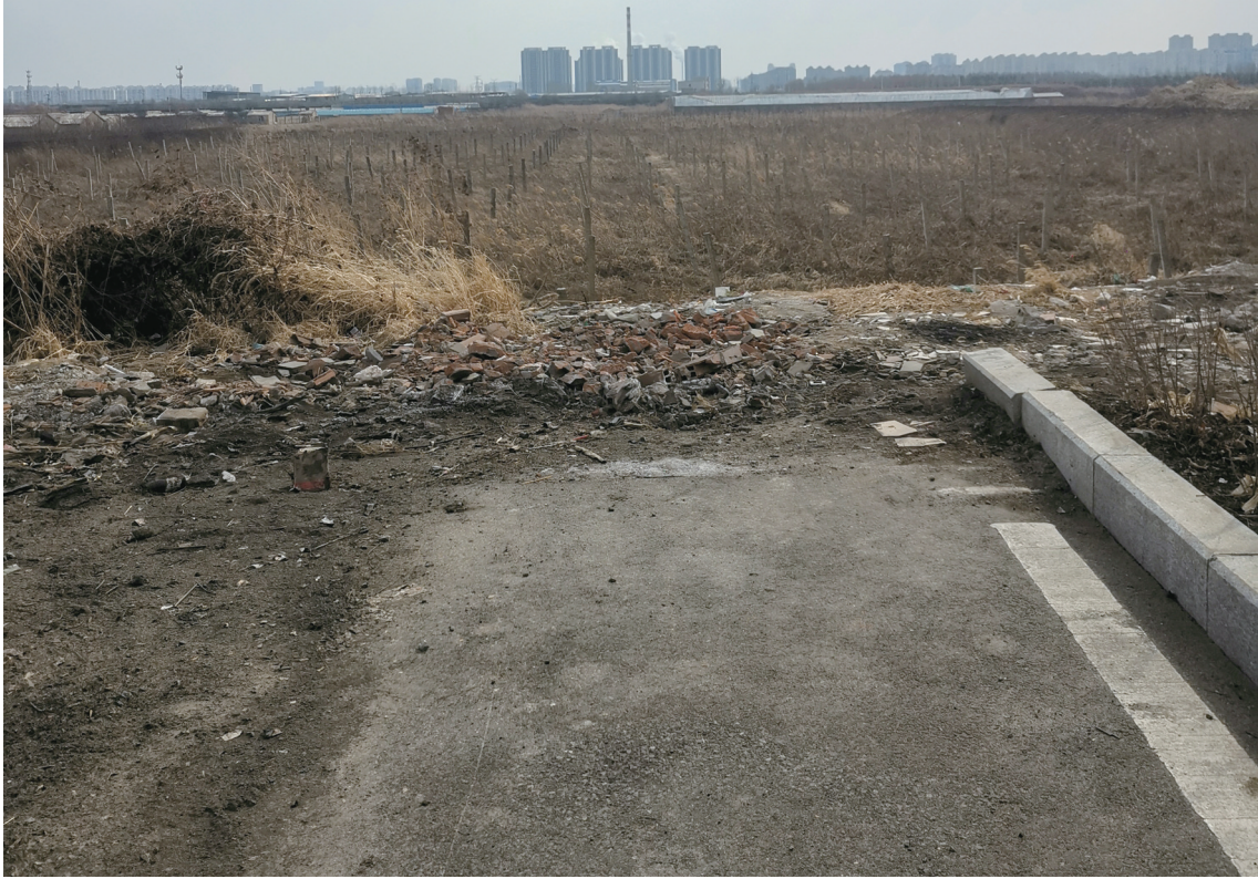
盛北大街向南“断头”处,与新开大街“隔岸”相望 本组图片 城市晚报全媒体记者 吕闯 摄
