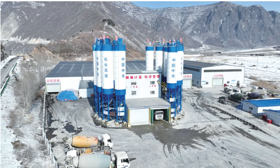
松长项目施工现场 本组图片 省交通宣传中心供图
