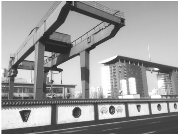
地铁施工现场
