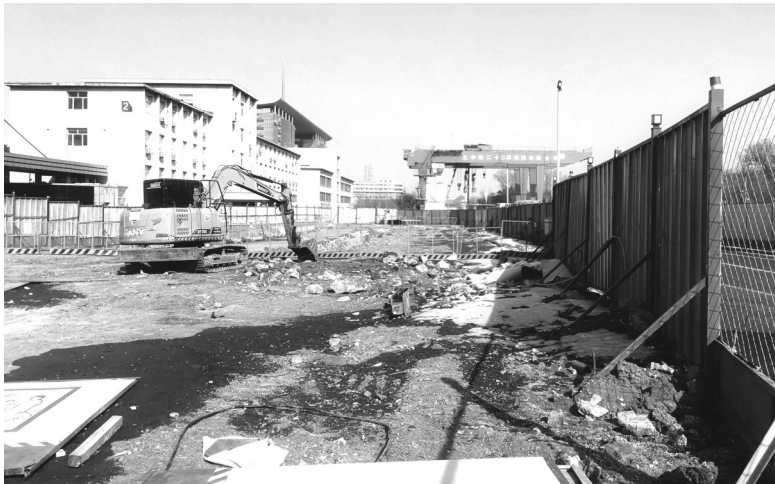
大型机械进驻工地 本组图片 城市晚报全媒体记者 刘佳雪 摄
