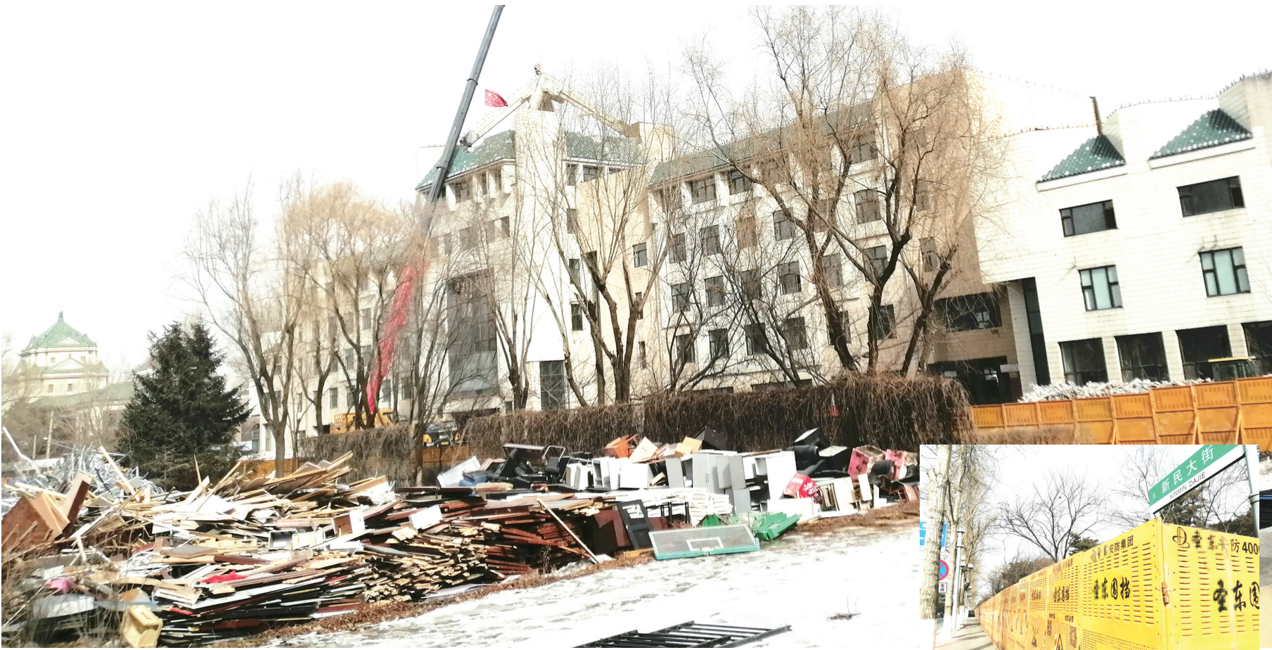
机械施工现场
