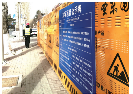
一施工人员走过公示牌
