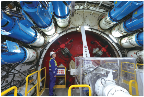
2月25日,中铁十四局技术人员在甬舟铁路金塘海底隧道“甬舟号”盾构机内关注设备运行情况。新华社记者 黄宗治 摄
