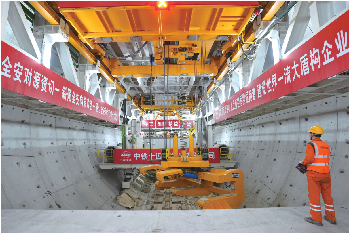
2月25日,中铁十四局技术人员在甬舟铁路金塘海底隧道“甬舟号”盾构机内调试箱涵吊机。 新华社记者 黄宗治 摄
