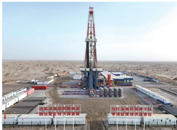
向地球深处进军!中国石油集团2月20日宣布,我国首口超万米科探井——深地塔科1井日前成功在地下10910米完钻,成为亚洲第一、世界第二垂直深度井,首次发布万米以下取得的岩芯标本,实现“深地”领域的重大突破。
