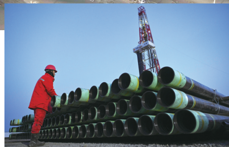
2月20日清晨,工人在中国石油塔里木油田深地塔科1井施工现场检查套管。新华社记者 胡虎虎 摄
