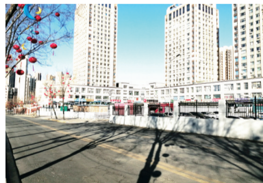
通道砌墙封闭
