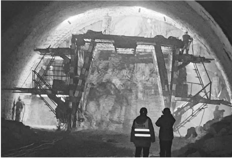
老岭隧道出口施工现场 本组图片 吉高集团供图
