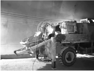
施工人员现场作业
