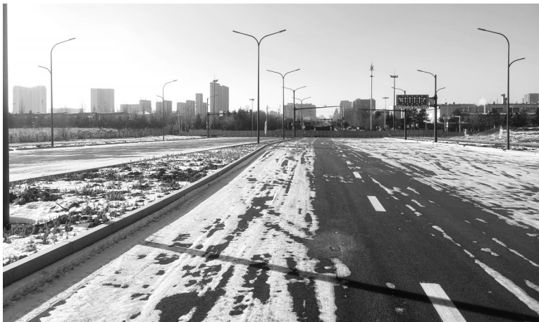
延长段沥青路面已基本施工完毕 本组图片 城市晚报全媒体记者 吕闯 摄
