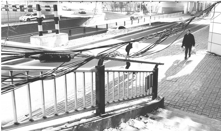
线缆横跨过街天桥 城市晚报全媒体记者 刘佳雪 摄
