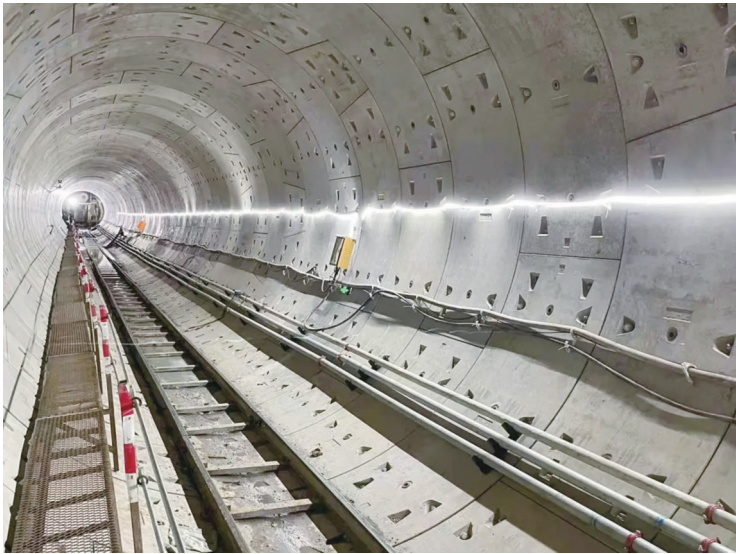
2号线东延工程实现洞通、轨通、电通 长春轨道交通集团供图
