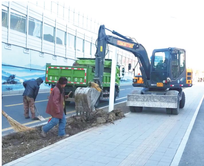
挖掘机作业 城市晚报全媒体记者 刘佳雪 摄
