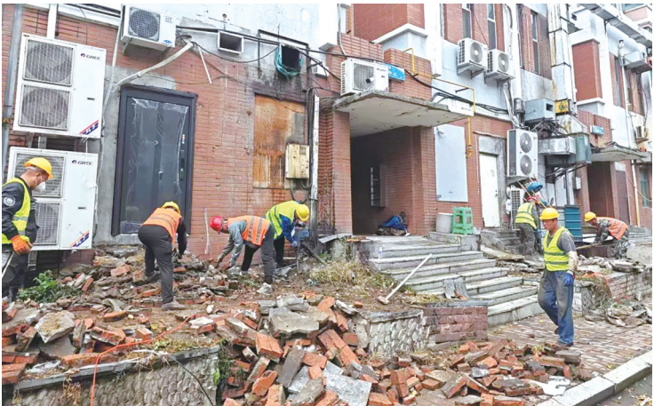
拆除违法占地的建筑 高新区城市管理局供图
