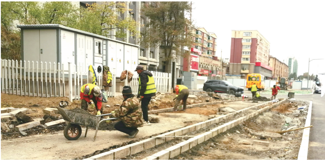
施工人员正在改造人行道 城市晚报全媒体记者 刘佳雪 摄
