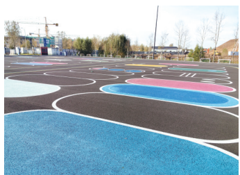
停车场有213个停车位和10个充电桩
