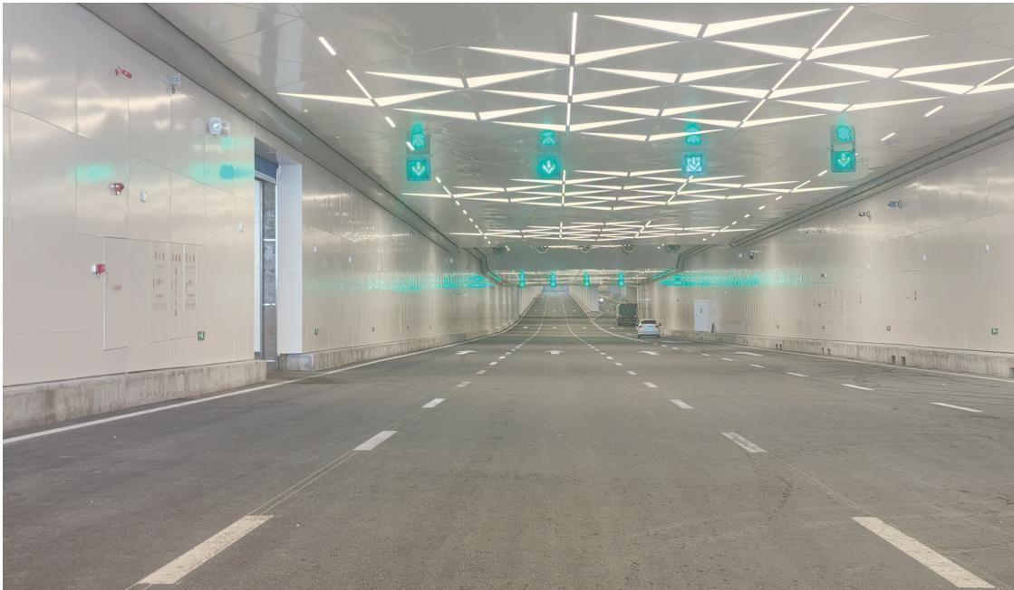
隧道内部 本组图片 城市晚报全媒体记者 陆续 摄
