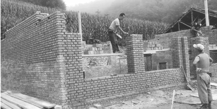
9月23日,吉林省临江市苇沙河镇大松树村组织村民开展灾后重建。受访者供图
