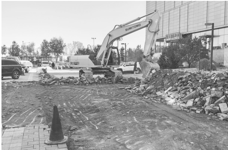
施工人员对原有的石板路面进行拆除 城市晚报全媒体记者 陆续 摄
