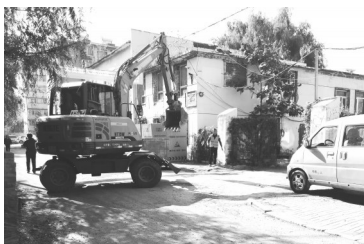
大型机械设备施工中
