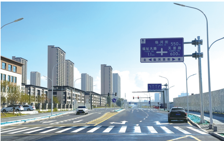
长春市南关区丙十七路打通 本组图片 城市晚报全媒体记者 陆续 摄
