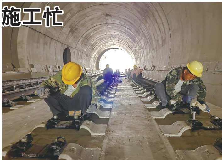
上屯隧道无砟轨道扣件安装 项目部供图
