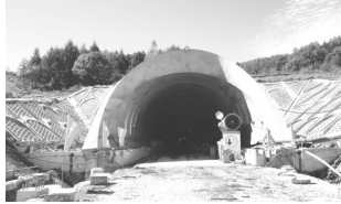
庙岭隧道顺利贯通 长春站供图
