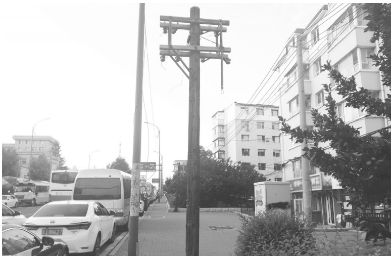
废弃线杆立在人行道旁 城市晚报全媒体记者 刘佳雪 摄
