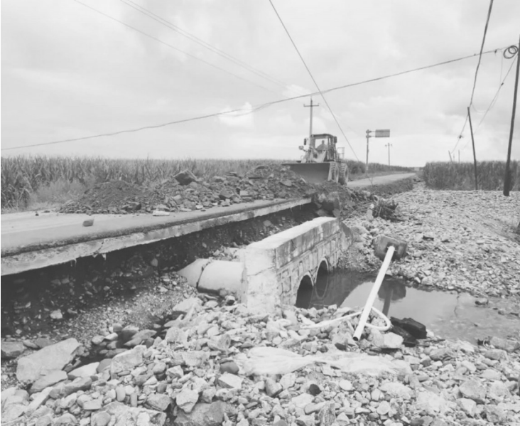
机械设备抢通作业中 省交通运输厅供图
