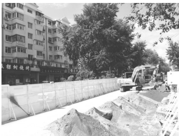
现场正在施工
