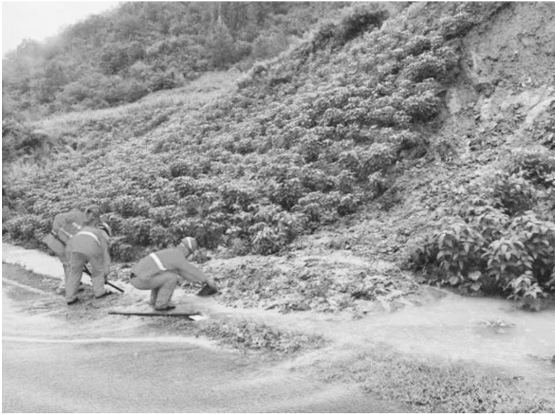
清理塌方 本组图片 白山市公路处供图
